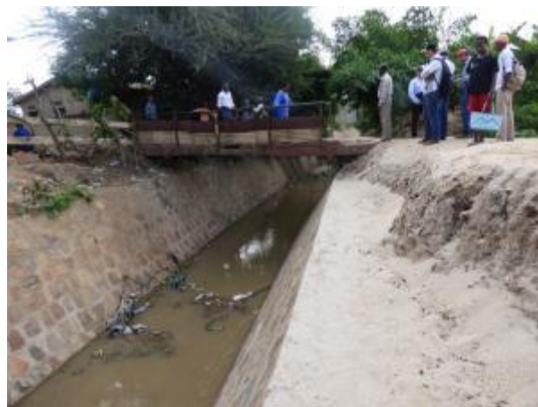
Photo 4: Passerelles existantes sur la rivière Nyabagere (Photo prise le 11 Mars 2015)
