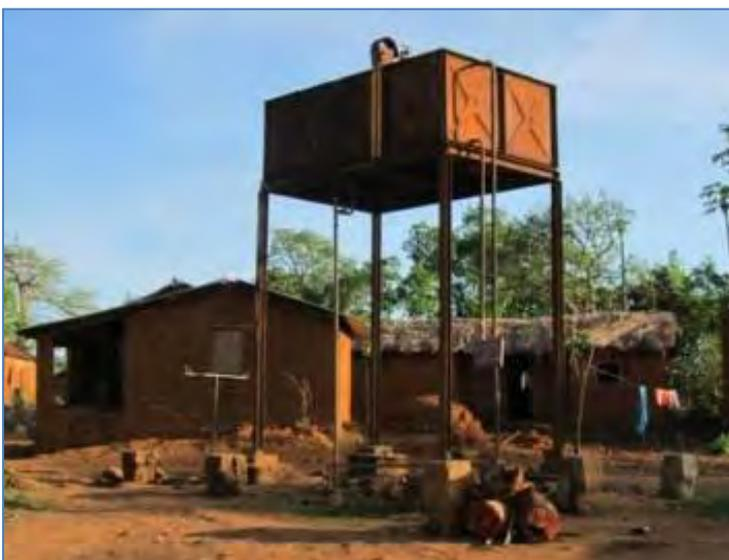
Ce réservoir a une faible capacité : 10 m<sup>3</sup>. Il est destiné à alimenter le village de Soyo. Il n'est plus fonctionnel car présentant énormément des fuites. Ce château d'eau sera remplacé dans le cadre du projet. Pour des raisons de sécurité évidente, son périmètre doit être clôturé.
