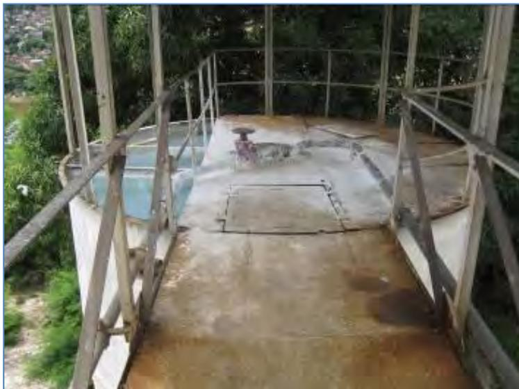
La passerelle conduisant au réservoir de lait de chaux et le couvercle de ce dernier sont dans un état de dégradation (oxydation) incompatible avec les normes de sécurité sur les lieux de travail.
