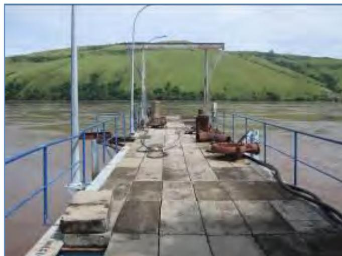
Les conditions de travail sur la passerelle ne présentent pas toutes les conditions de sécurité requise à cause d'une présence d'un garde-fou assez sommaire, de l'absence d'une lisse basse et d'un accès plus ou moins dangereux aux vannes et clapets,
