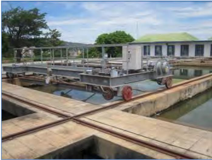
Les bassins de floculation et sédimentation ne disposent pas de protection contre les risques de chutes et de noyades. L'éclairage des installations est non fonctionnel. Les ponts racleurs seront complètement réhabilités
