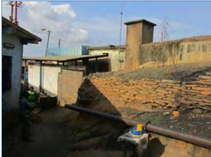
Ce réservoir est à une altitude élevée ; son réseau de distribution est fort étendu. Son alimentation à partir de l'usine de Soyo et même depuis R4, est sporadique. Le repompage vers R5 s'effectue avec une pompe de 130m<sup>3</sup>/h de 110 HMT. La parcelle doit être clôturée de manière à protéger les installations de toutes constructions illégales
