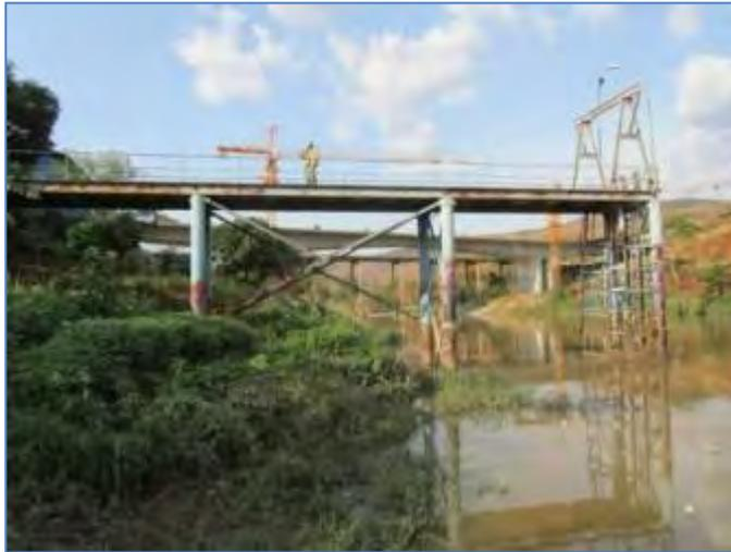
Le pompage est réalisé par 4 pompes immergées de 460 m<sup>3</sup>/h d'une puissance de 130 kW. Il sera nécessaire de mettre en place une plateforme amovible, positionnable au niveau de l'eau (crues). Le nettoyage des crépines, qui se bouchent assez souvent, nécessite la présence d'un plongeur.
