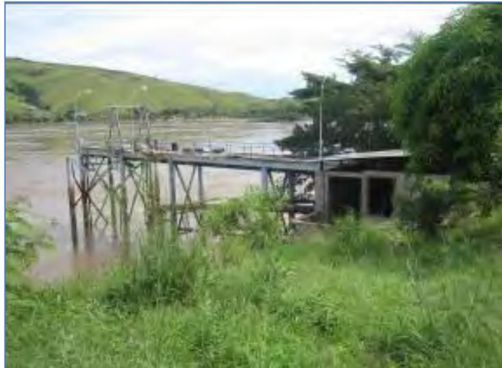
Une vue de la station de pompage des eaux dans le fleuve Congo à Matadi. Les équipements et bâtiments sont dissimulés dans la végétation arborée. Il est recommandé de protéger les équipements par des clôtures adaptées. Le pompage se fait à partir d'une passerelle d'une quinzaine de mètres. L'accès est assez dangereux dans le contexte d'une exploitation normale. Des bouées doivent être positionnées en permanence pour prévenir les accidents.
