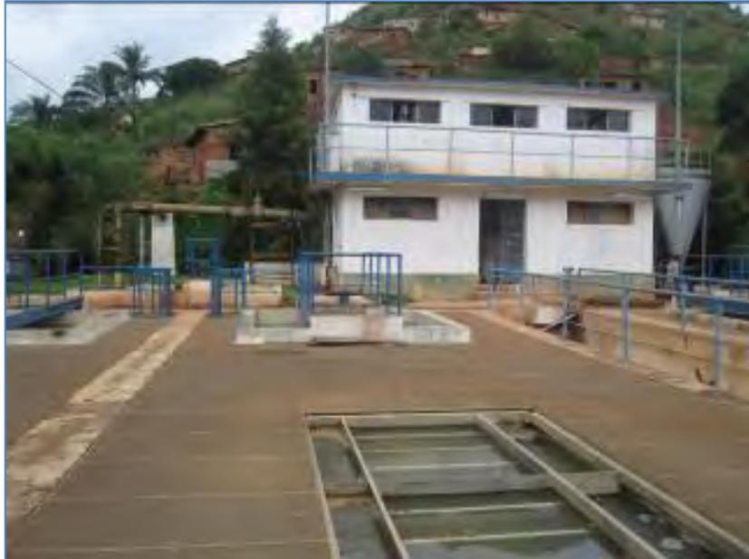
L'usine de Soyo était alimentée par les seuils Léopold et Robert construits respectivement en 1900 et 1930. Elle reçoit 7.900 m<sup>3</sup>/jour. Les flocculateurs sont des cuves en béton de 4x35 m<sup>3</sup>. Les décanteurs lamellaires ont une capacité de 140 m<sup>3</sup> pour 75 m<sup>2</sup>.
