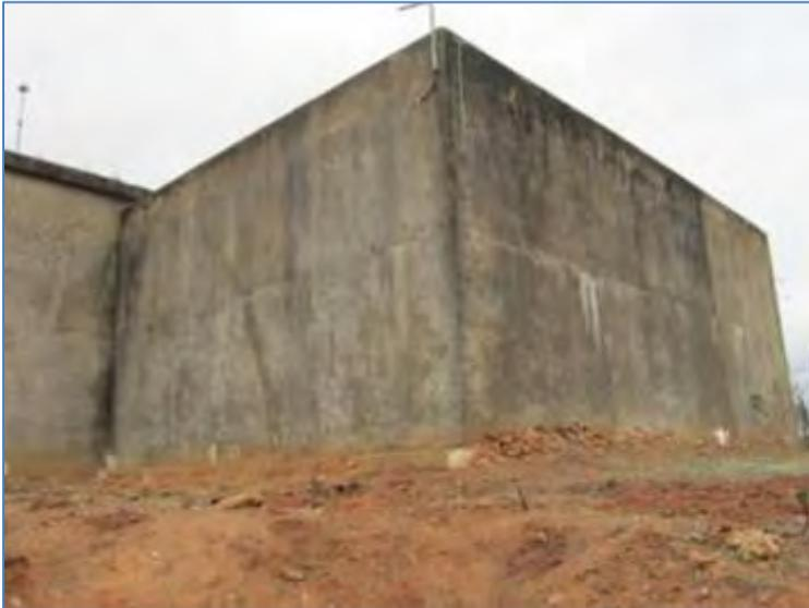
Il comporte 2 cuves de 500 m<sup>3</sup> de capacité. Il est situé très en hauteur en bord de falaise, avec peu de terrain disponible. Son périmètre doit absolument être protégé et clôturé
