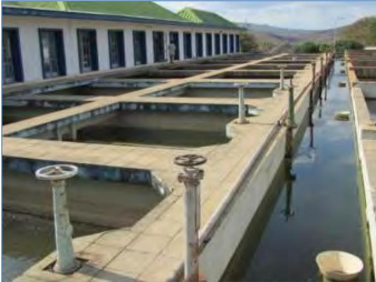
Batterie des filtres à l'usine du fleuve, sans aucune protection contre les risques de noyade.
