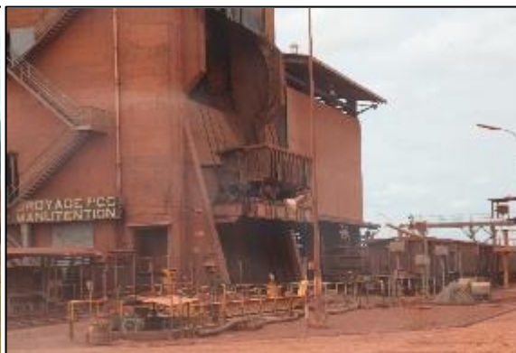
Figure 39 : Concasseur au terminus du chemin de fer (Kamsar)
