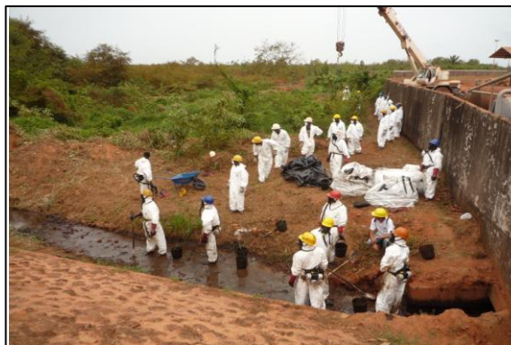
Figure 51: Pollution aux hydrocarbures à Kamsar
