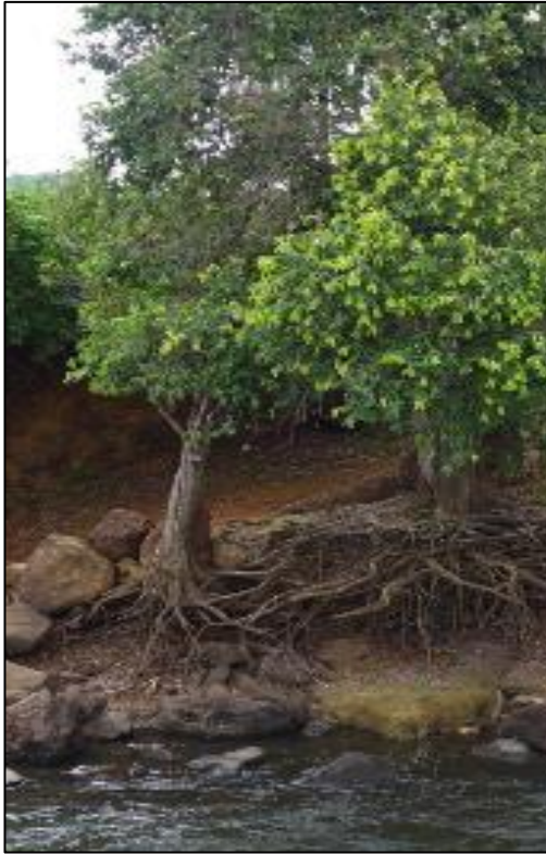
Figure 54: Déchaussement des arbres à l'aval immédiat du seuil de la prise d'eau sur le Kogon à la CBG à Sangarédi
