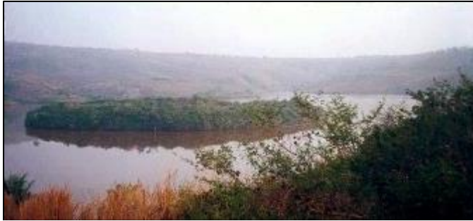
Figure 48: Vue du bassin à boues rouges de Fria (photo Trébaol, 1998)
