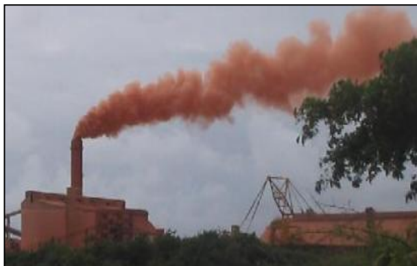
Figure 36 : Emission de poussières par l'usine de déshydratation de la CBG de Kamsar avant installation du système de traitement en 2005. Depuis, cet impact a été fortement atténué.
