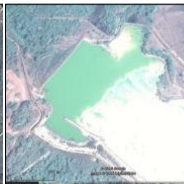
Figure 47: Vue d'un bassin à boues de la SAG à Siguiri ou de la SEMAFO
