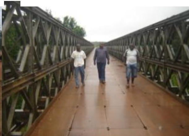
Pont Lua en Bon état
