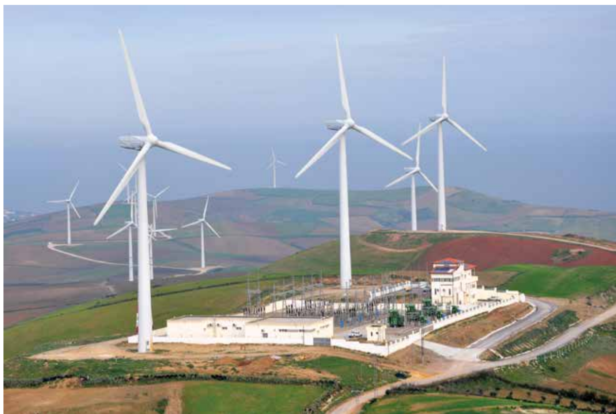
Parc éolien de Métlina en Tunisie.
