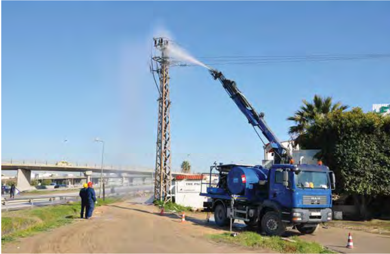
La bonne maintenance assure la disponibilité adéquate en électricité.
