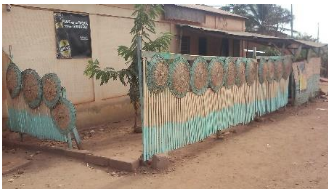
Photo 12: Hangar du bar impacté sur le tronçon 3
