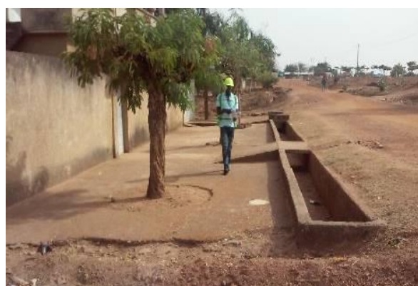
Photo 6: Terrasse aménagée le long d'une maison
