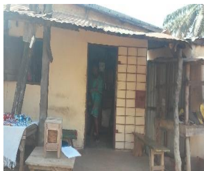
Photo 10: Auvent de boutique sur le tronçon 2
