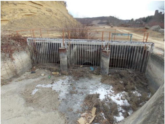
Partskhisiinverted siphon inlet
