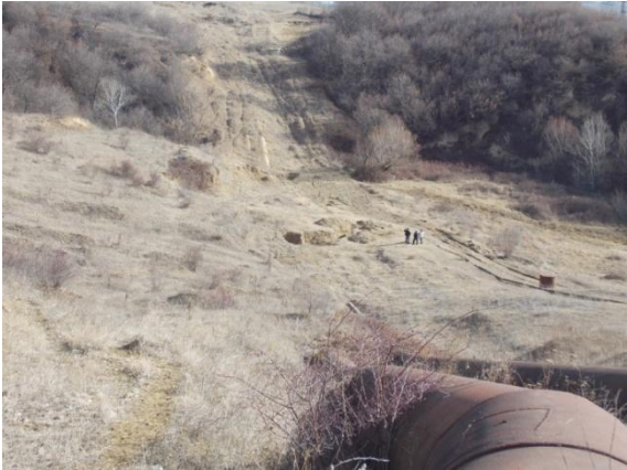
Bogviinverted siphon corridor
