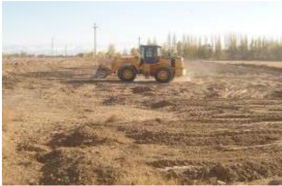
土地平整 Land leveling
