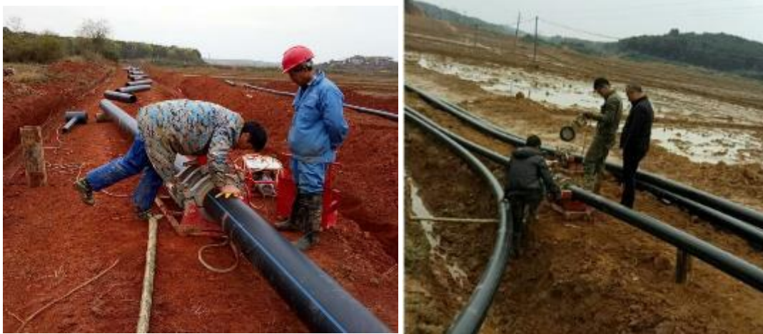
项目区PE管道高效节水灌溉系统安装
