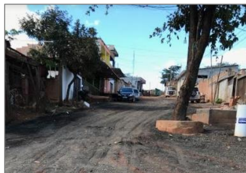
Figura 3: Lançamento de material frisado em via, Ocupação Rosa Leão (Fonte: CREURB, 2020)
