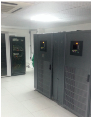
SYSTEME CENTRAL D'ONDULATION
