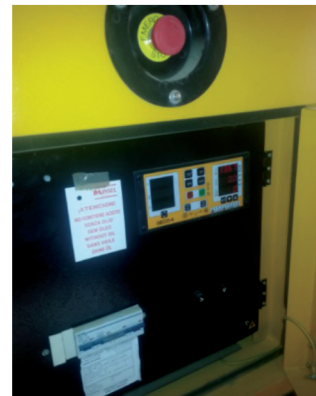
GRUPE ELECTROGENE AVEC DEMARRAGE AUTOMATIQUE
