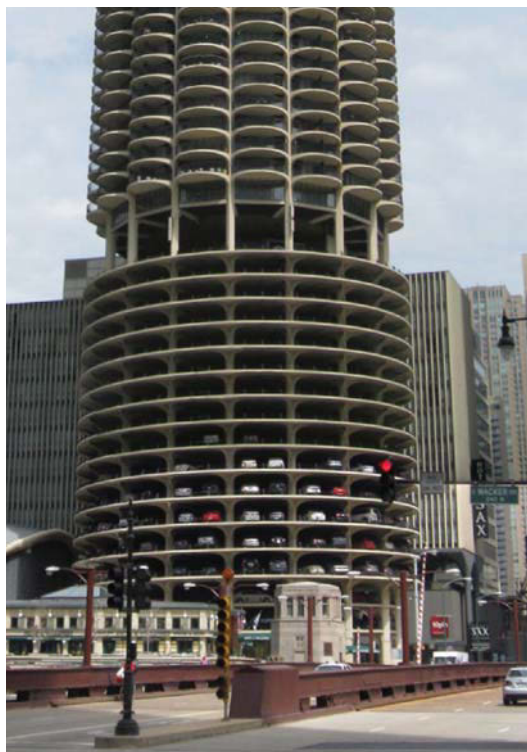
Figura 3.64 Edificio de aparcamiento en Marina Towers, Chicago
