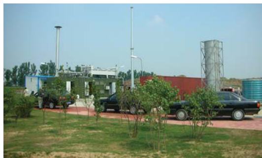
Figura 3.62 Instalación central de generación de electricidad y combustión del gas de vertedero, Tianjin, China
