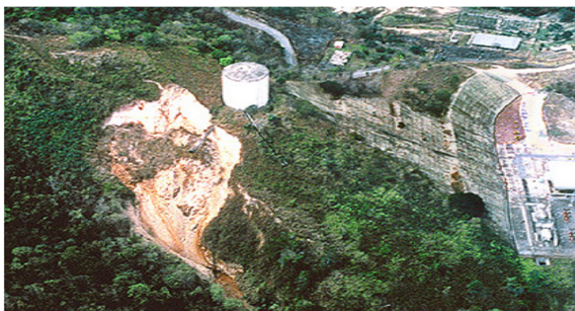
Tanque de Almacenamiento (Reservorio)
