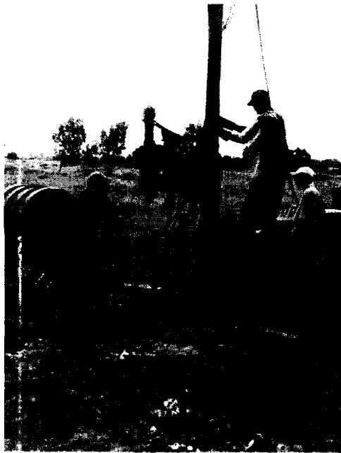
Foreuse Apageo utilisée pour la réalisation des sondages
