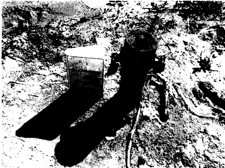
Installation du puits d'observation F6 Protecteur et cadenas
