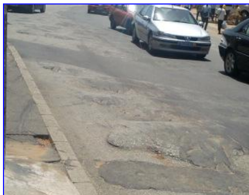
Photo 11 (1&2) : Déformation de la chaussée au niveau du carrefour de la CNPS et dégradations dans les environs du carrefour de la rue du Commerce
