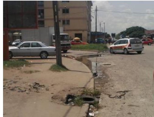
Photo 18 (1&2) : Forte dégradation de la voie au niveau du Commissariat de Biafra et Stagnation d'eau et fermeture fréquente de la voie au niveau carrefour « triangle »
