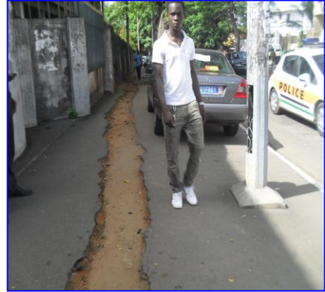
Photo 14 (1&2) : Vue de tranchées mal ou non réparées sur les trottoirs du Bd Clozel
