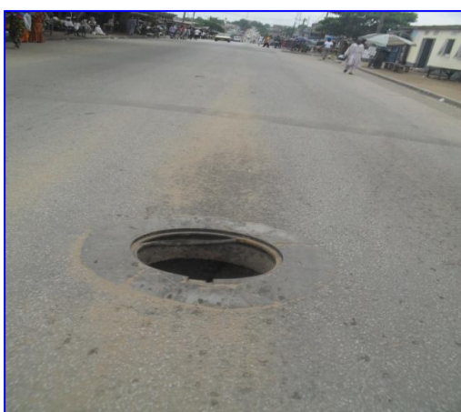
Photo 6 (1&2) : Regard découvert en pleine chaussée non loin du marché et autre regard sans tampon
