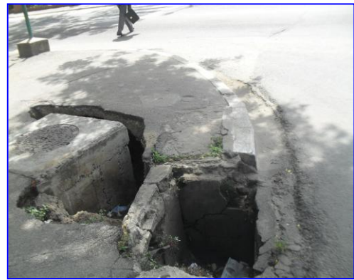
Photo 13 : Vue de l'état défectueux des ouvrages d'assainissement sur le Boulevard de la République
