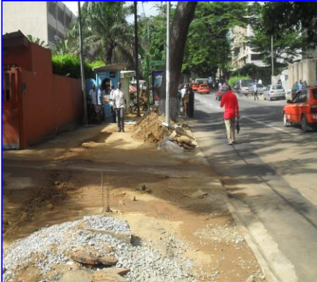
Photo 14 (1&2) : Vue de tranchées mal ou non réparées sur les trottoirs du Bd Clozel
