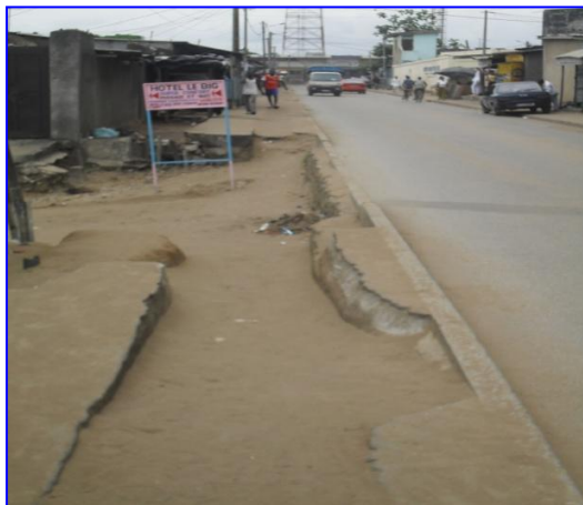
Photo 8 : Dégradation prononcée du trottoir de la V1 au niveau du quartier Kennedy
