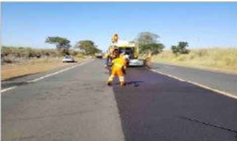
Foto 5: Execução de reparos (manutenção de rotina)
