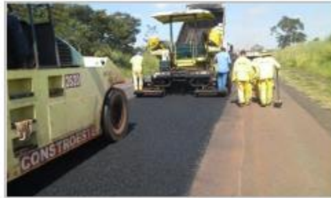
Foto6: Execução de reparos (manutenção de rotina)
