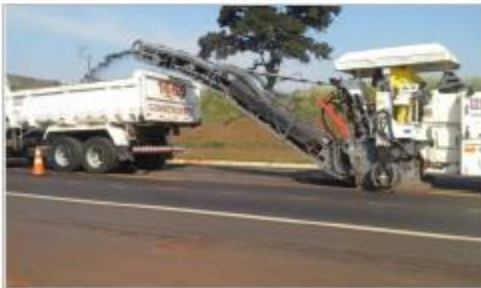
Foto 5: Execução de reparos (manutenção de rotina)
