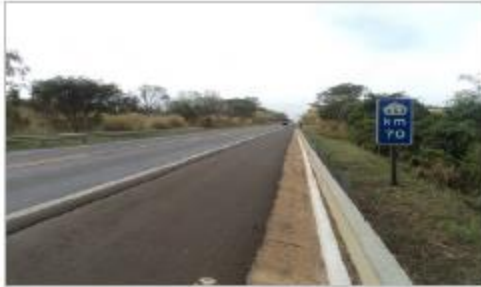
Foto 1: Vista do trecho concluído
