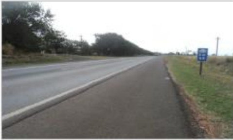
Foto 1: Vista do trecho concluído
