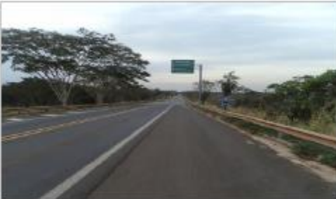
Foto 3: Vista do trecho concluído
