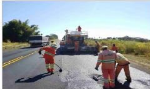
Foto 4: Execução de reparos (manutenção de rotina)
