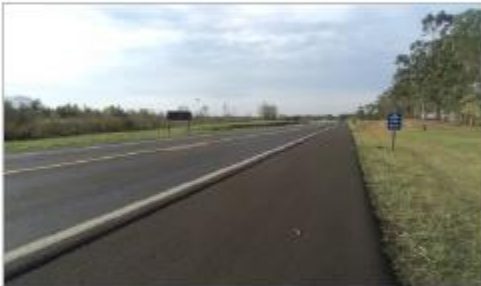
Foto 3: Vista do trecho concluído
