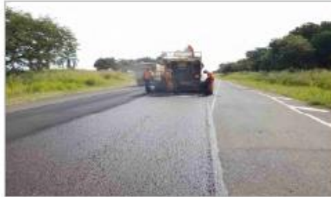
Foto 6: Execução de reparos (manutenção de rotina)
