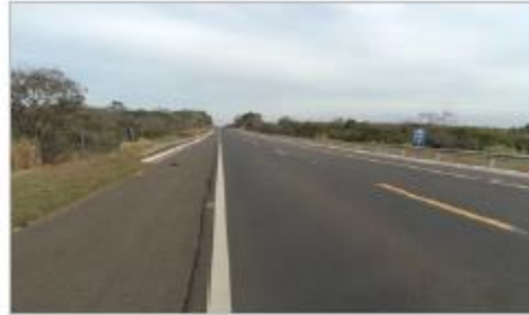
Foto 2: Vista do trecho concluído
