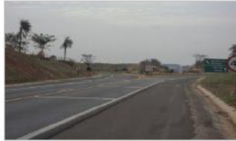
Foto 2: Vista do trecho concluído
