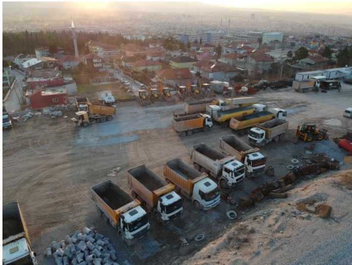
Şekil 3.1. DES-W1 Şantiye Alanı
