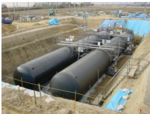
Рисунок 10. Один из 47 резервуаров системы аварийного водоснабжения в городе Кобе
