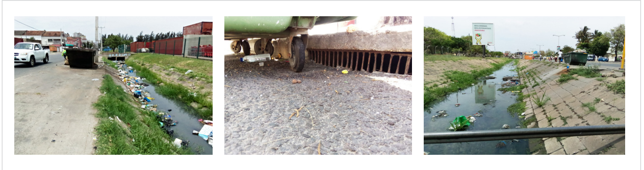
Figura 43 Exemplos de contentores localizados na proximidade imediata de sistemas de drenagem em Maputo
