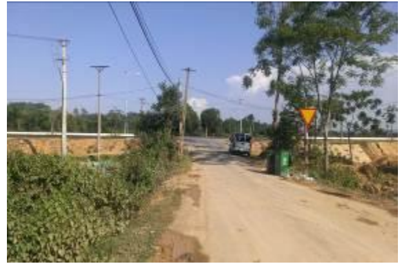
Nút giao Hoàng Văn Thái (Km5+00)
