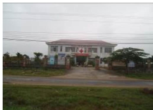
Trạm y tế xã Hòa Nhơn (Km1+383)
