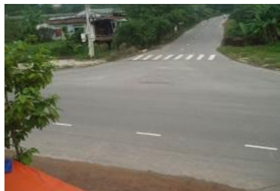
Cuối tuyến giao ĐT 602 (Km9+228)
