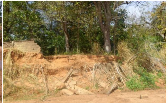
Photo 10: Erosion sur le mur de l'ONEA (Burkina Faso)
