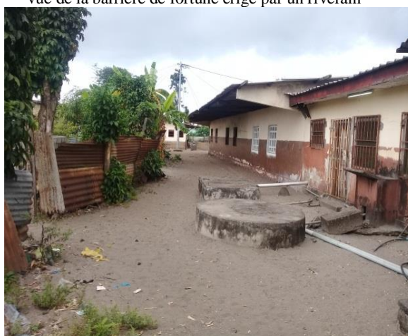
Photo 2 : Ecole saint Paul des Bois, vue de la barrière de fortune érigé par un riverain
