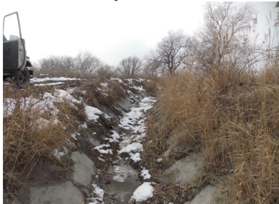
Main canal. pk140+00
