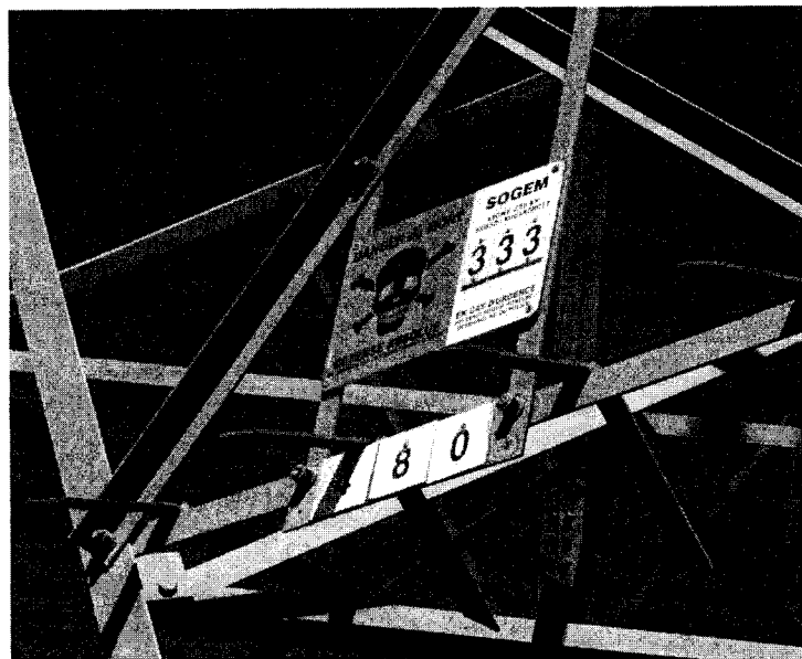
Figure 11 : Exemple de plaque signalétique (source : Tractebel Engineering)
