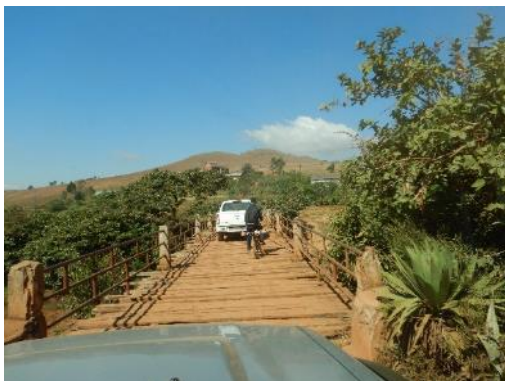
Type d'ouvrage de franchissement (vers gîte Tsinjoarivo)
