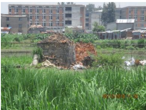
Tas de briques destiné à la vente
