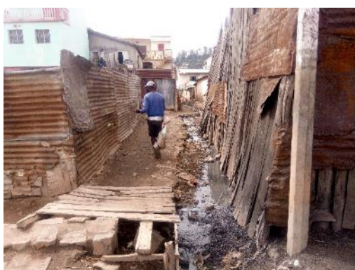
Eaux usées déversées dans le bassin
