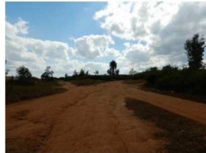
Piste d'accès au site
