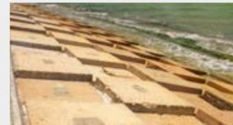
**Structures de sacs de sable :** Elles arrêtent ou ralentissent temporairement les effets de l'érosion côtière. Elles sont généralement placées à l'avant et parallèlement au rivage pour empêcher les forces destructrices de la mer d'atteindre les structures côtières. Elles ne doivent être utilisées que comme des interventions à court terme ou temporaires.
