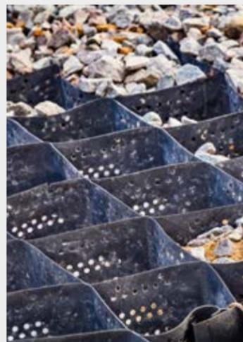
**Géonappes ou géogrilles synthétiques anti-érosion :** Couvertures souples et perméables, faites de fibres synthétiques maintenues ensemble par des mailles plates ou des trames tridimensionnelles. Présentant la même fonctionnalité que les géogrilles organiques, elles protègent le sol et facilitent le développement et le renforcement de la végétation. Pour les pentes raides, les nattes composites de renfort constituent une bonne option.
