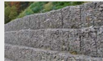
**Gabions :** paniers grillagés remplis de façon compacte de pierres, de galets ou de cailloux concassés. Ils sont couramment utilisés pour prévenir l'érosion et pour stabiliser les berges, les falaises et les pentes de dunes. Les gabions sont adaptés aux plages à faible énergie et sont idéalement placés au-dessus de la zone de marée car ils ne sont pas assez durables pour résister à l'action directe et régulière des vagues<sup>85</sup>.
