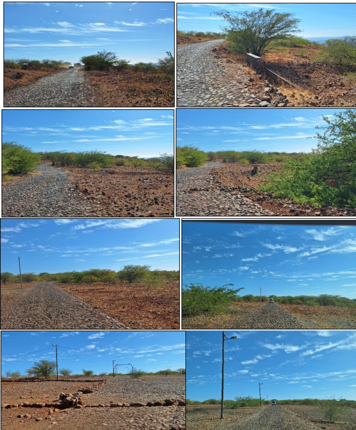
Ilustrações 1 - Estrada de acesso à Fortaleza Forte Real de São Filipe, a ser reabilitada no âmbito do presente projeto, Cidade Velha.
