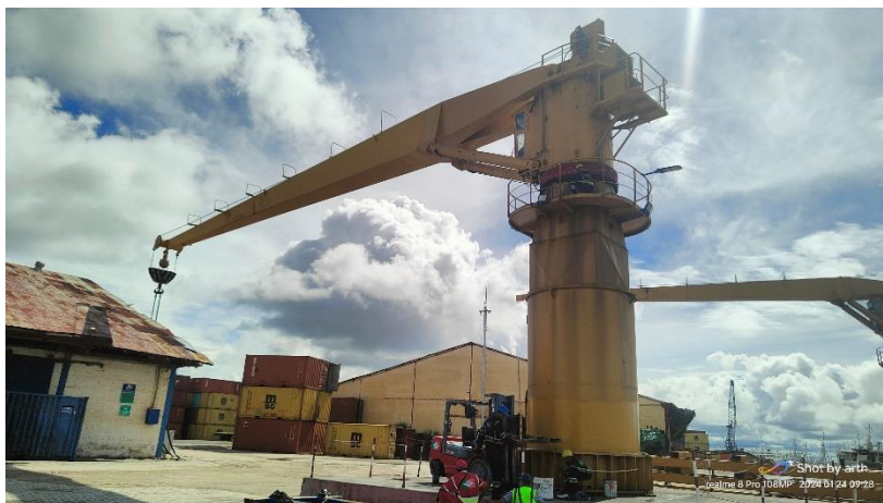
Photo 5 : Bigue fixe se trouvant dans la partie à aménager
