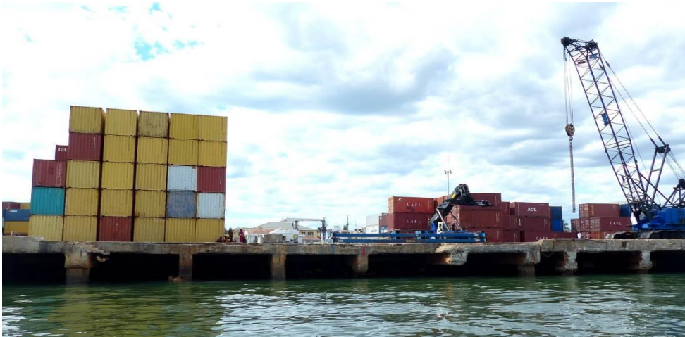
Photo 2 : Etat actuel du quai Vuillemin
