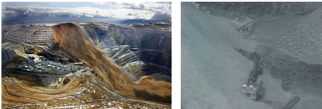
Figura 9-18 Riesgos de aplastamiento por derrumbe
