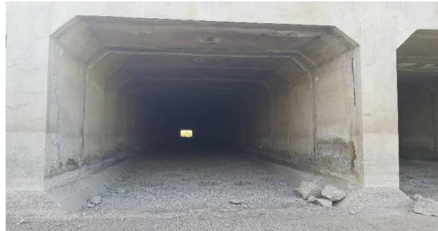
Grand dalot de 7 cellules drainant la rivière Any sous la piste de l'AICH
