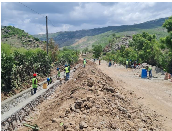
Sécuriser les excavations à l'aide des produits de fouille
