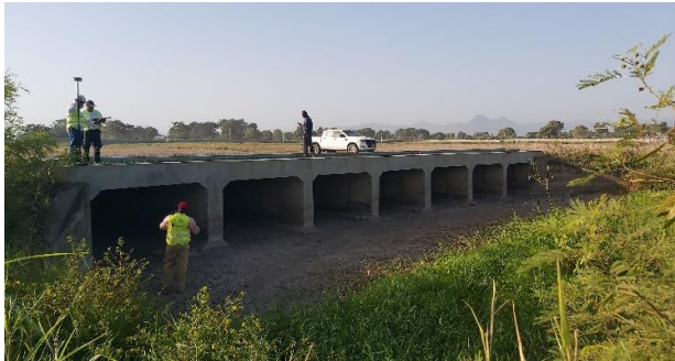
Grand dalot de 7 cellules drainant la rivière Any sous la piste de l'AICH
