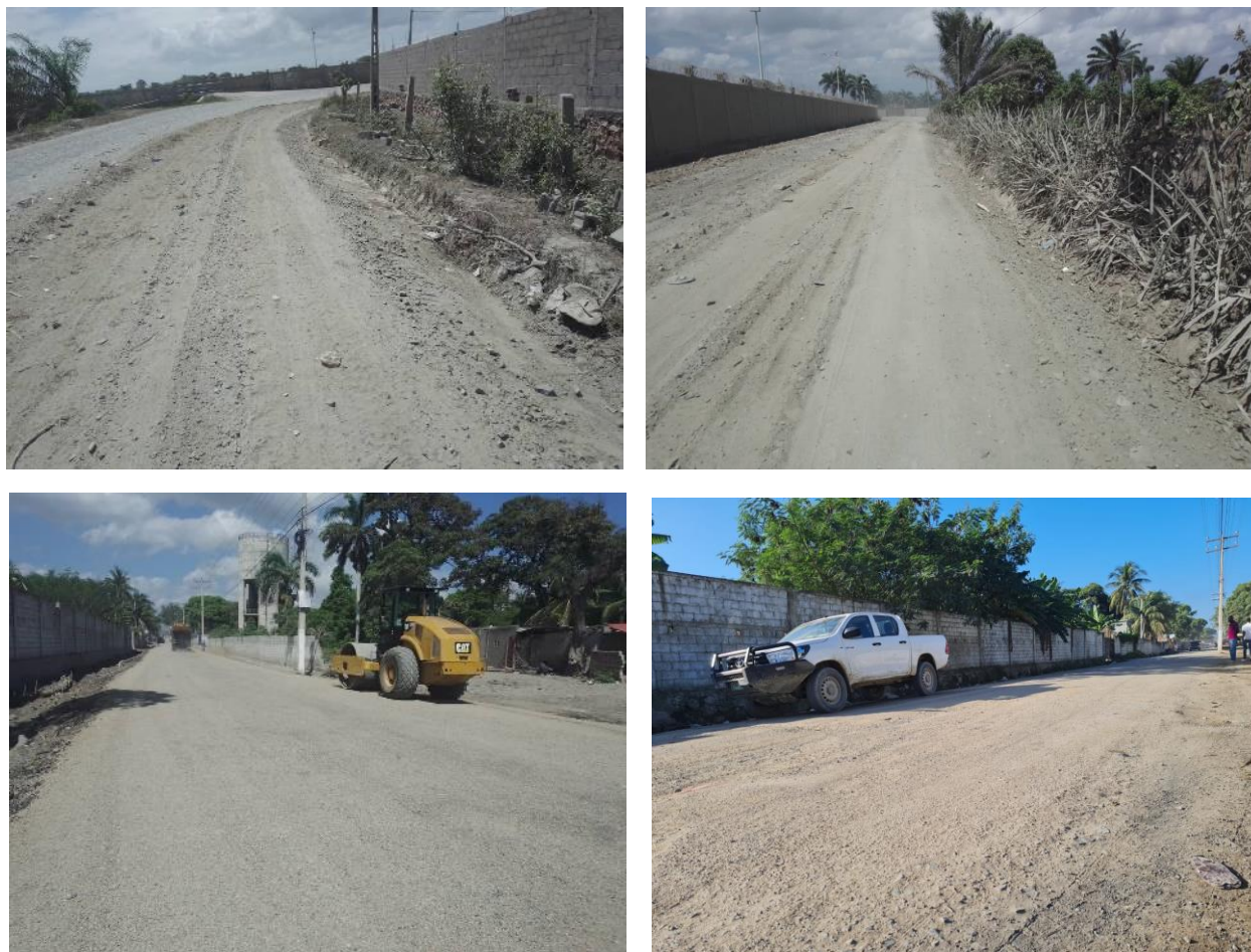
Figure 5. Vues de la route SOS pendant et après les travaux d'amélioration de juillet 2021
