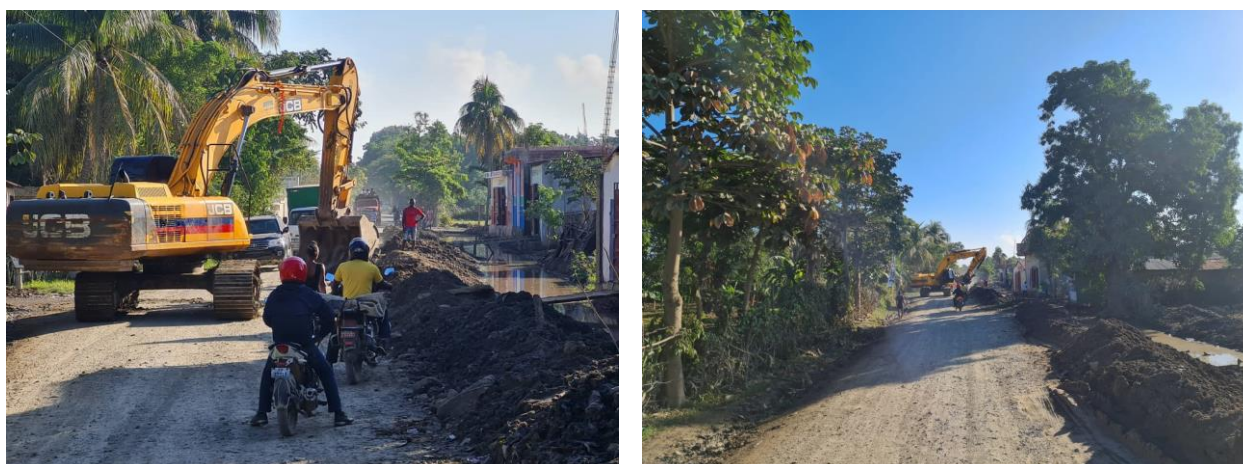
Figure 6. Travaux de curage par le MTPTC le long de la route SOS (Photos UCE/MTPTC, 27 janvier 2021)
