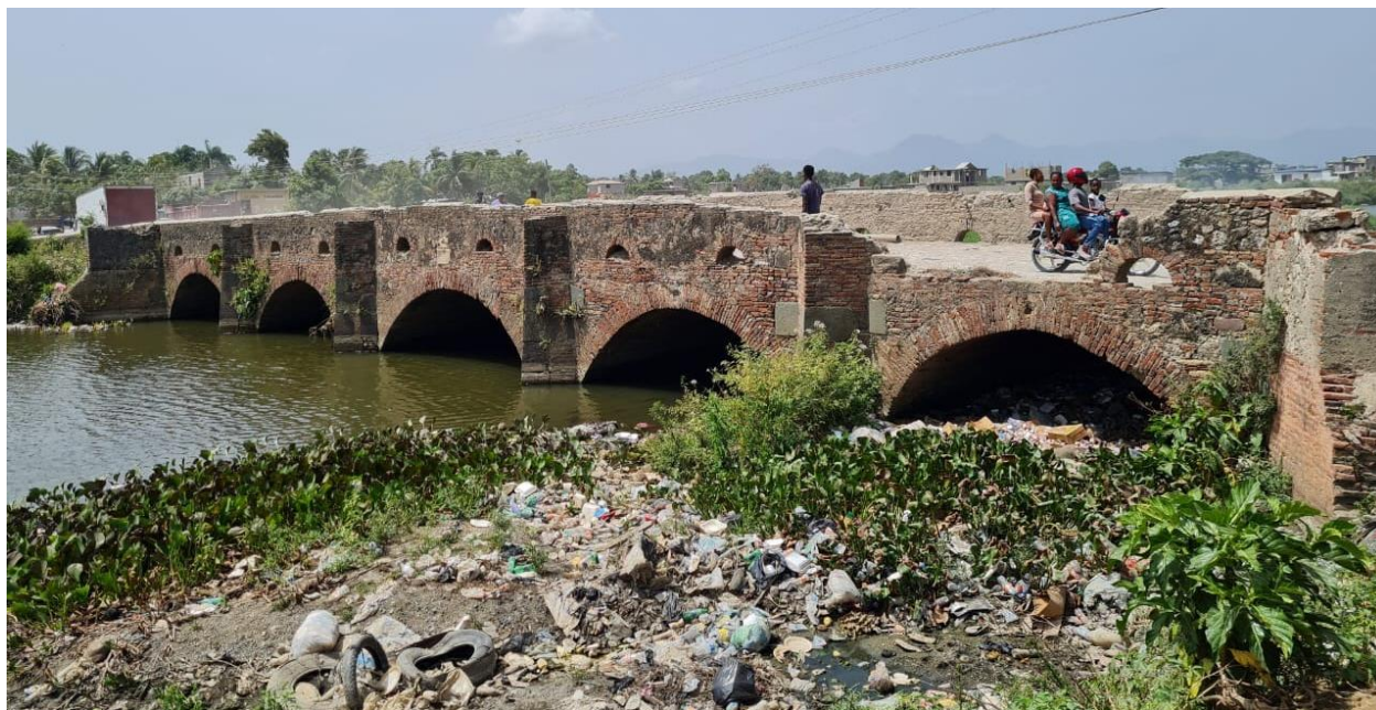
Quelques vues de la structure du pont jeté sur la rivière du Haut du Cap en 1847 (appelé communément pont colonial)
