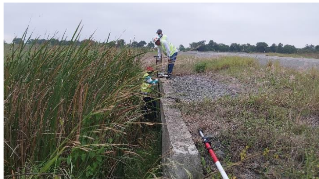
Vue de l'engorgement des canaux de drainage au sein de l'AICH
