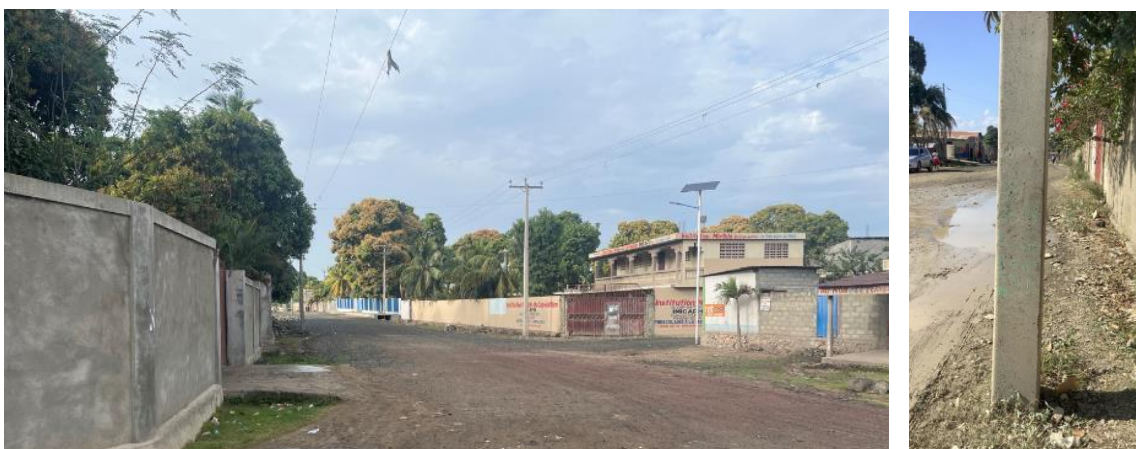
Poteaux électriques à déplacer dans le cadre des travaux
