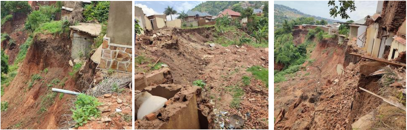
Photo 10 - Destruction des maisons au bord de la rivière Nyanzari
