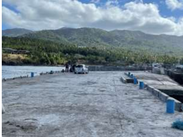
Photo 8: Quai existant à démolir
