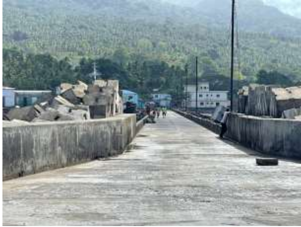
Photo 4: Aperçu de la jetée d'accès
