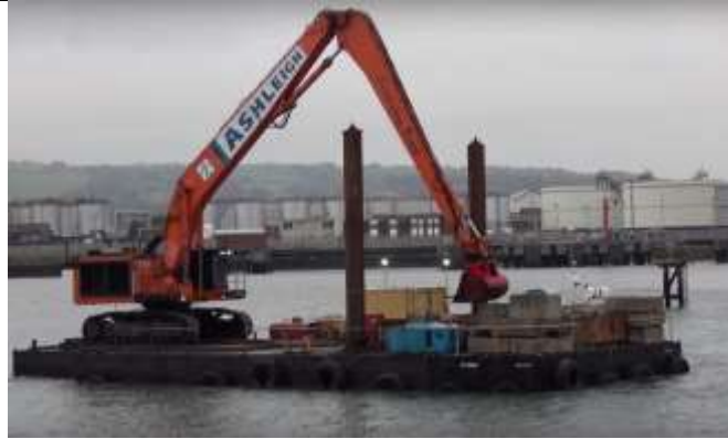
Photo 9 : Excavatrice sur ponton flottant
