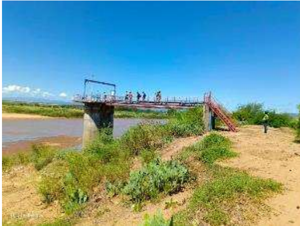
Photo 2 Aperçu de la zone de captage
